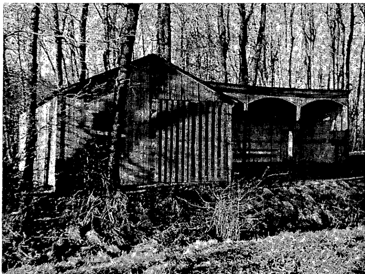
Pavillion og Skydehus
